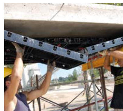
⑧ DÉCOFFRAGE PANNEAUX GEOPANEL
