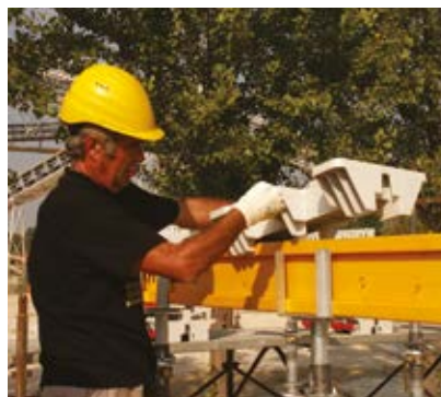
② INSTALLATION POUTRELLES H
