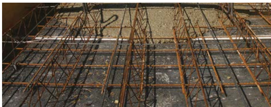
⑤ COULAGE BÉTON
