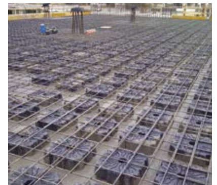
⑥ PAUSE ENTRE PREMIER ET DEUXIÈME COULAGE
