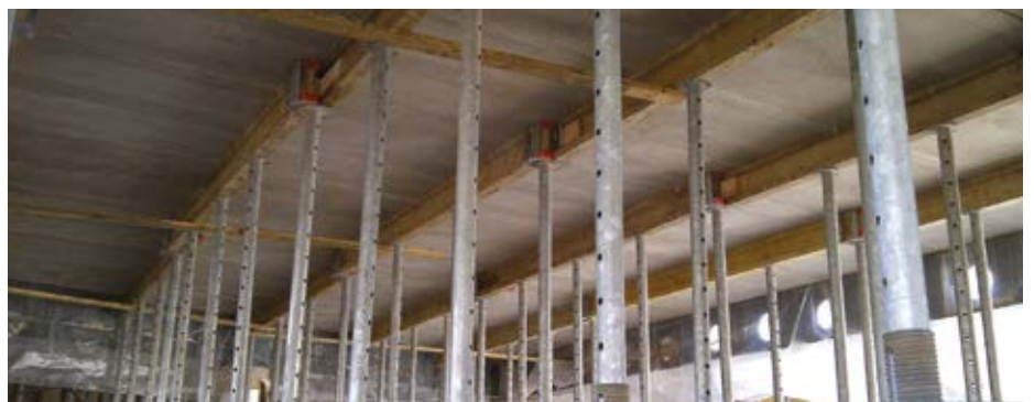
⑧ DÉCOFFRAGE DE BÉTON
