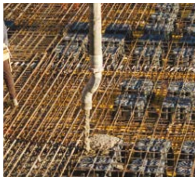
⑤ PREMIER COULAGE DE BÉTON
