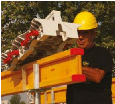
① Y-TRÄGER + KEIL PLATZIEREN
