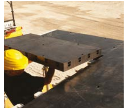
③ GEOPANEL-PANEELE PLATZIEREN
