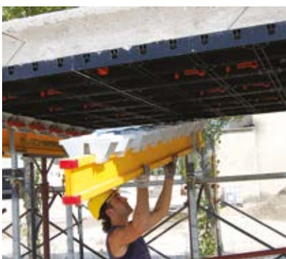
⑥ H-TRÄGER ENTFERNEN
