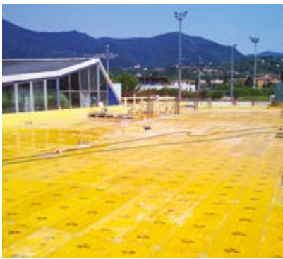
① VORBEREITUNG DES GERÜSTS
