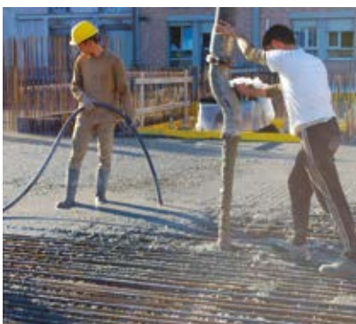
⑦ 2. PHASE BETONGUSS
