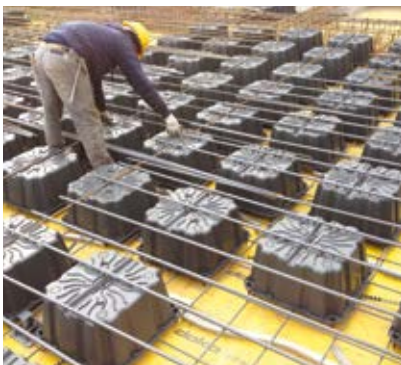
④ VERLEGUNG DER OBEREN BEWEHRUNG
