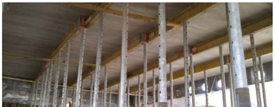
⑧ AUFSTELLUNG DER STÜTZEN
