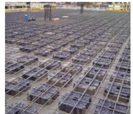
⑥ PAUSE ZWISCHEN 1. UND 2. BETONGUSS
