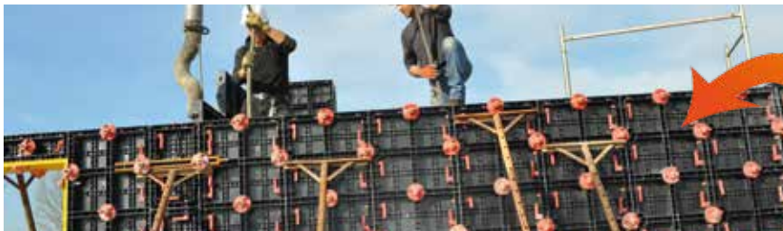
POUR OF CONCRETE WALLS
