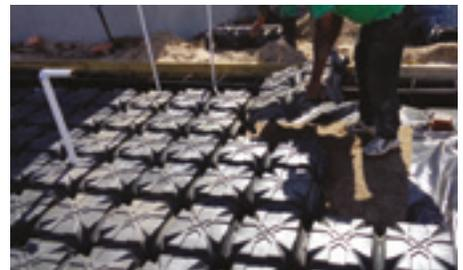
COLOCACIÓN DEL ENCOFRADO
