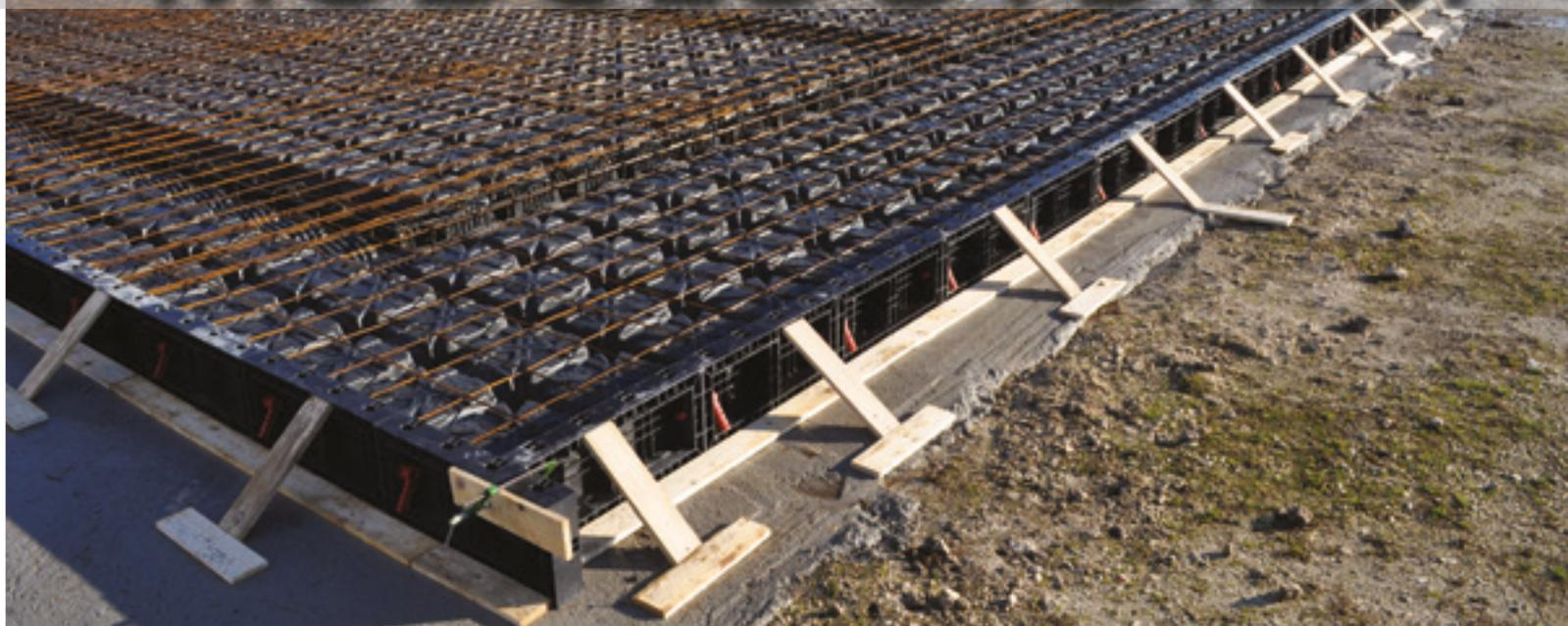
Sistema modular perdido para la realización de cimientos ventilados que proporcionan una barrera física entre el suelo y el edificio
